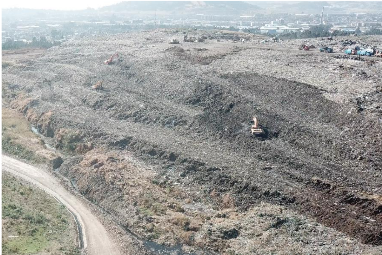
Travaux d'amélioration de la décharge de Koshe (Rappi) (2018)
