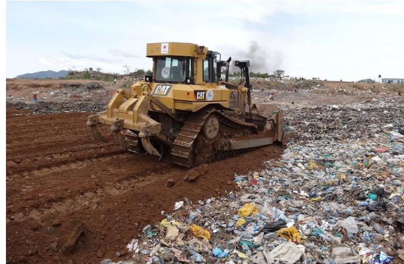
Amélioration du site d'élimination finale par un projet de coopération technique de la JICA (2013, Soudan du Sud)
