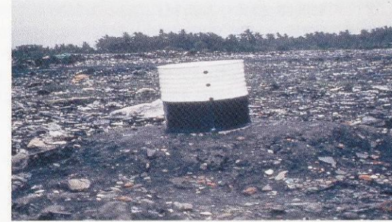
廃ドラム缶を使ったガス抜き設備
